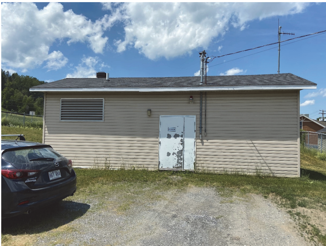
Photo 5 : Aperçu du bâtiment de production d'eau potable du puits PP-3 – 2020-06-22
